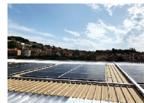
Instal·lacions acabades (setembre 2021)
